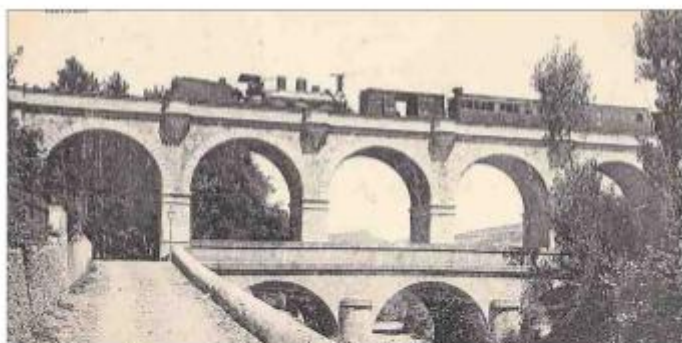
■ Le «Paris-Lamalou» en manœuvre sur le pont Carrel.
